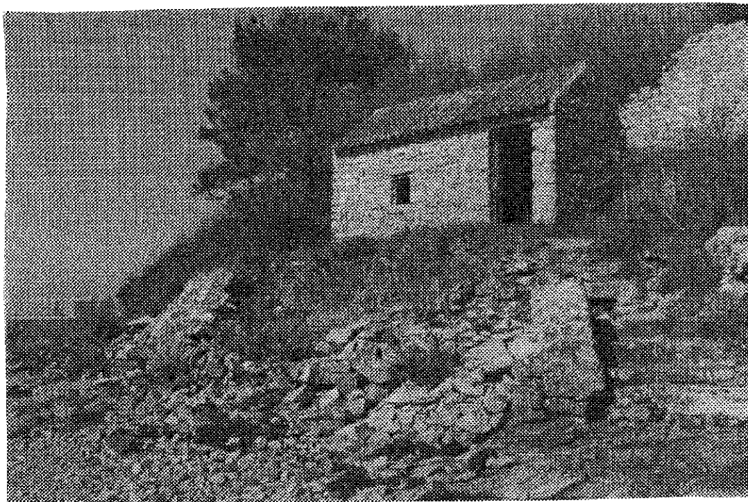
Guérite sur le chemin des douaniers à la Garenne
